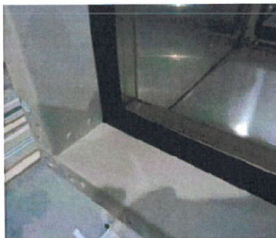
Cadre de raccordement anti-vibratoire (pour gaines)
